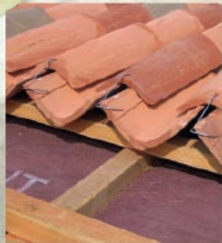
Il tetto in legno ventilato, coibentato e traspirante è realmente la soluzione definitiva per tutti i tipi di edilizia. Questa soluzione permette di usare in modo adeguato le guaine di tipo traspirante, e d'isolare correttamente il vostro tetto, inoltre la listellatura in legno consente di adattare ogni tipo di coppo o tegola vecchia e nuova.
